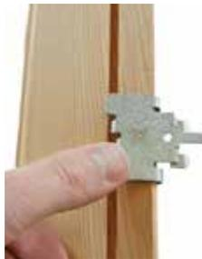
positionner le clip et le mettre en place avec une légère pression
