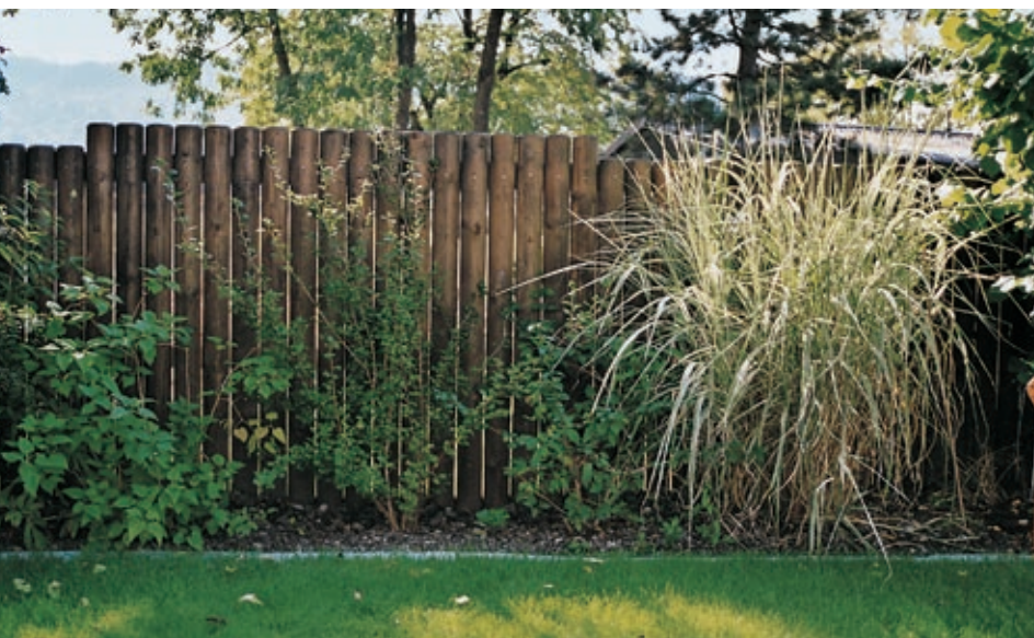
Sichtschutzwand mit Halbrundhölzern
