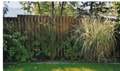
Sichtschutzwand mit Halbrundhölzern
